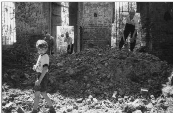
...и местные жители каждую субботу приходили очищать будущий храм от мусора
